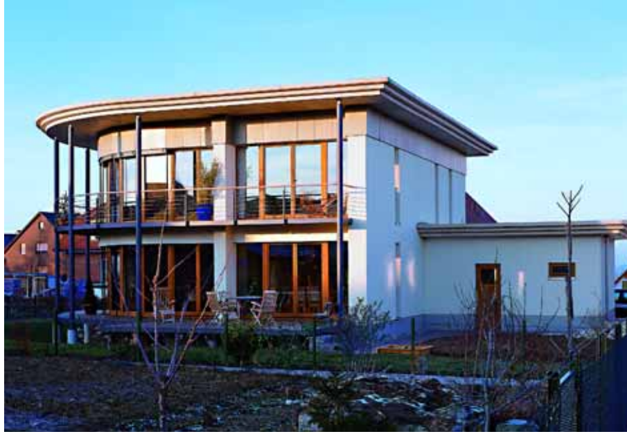
Pasif Isıtma Sistemli Ev: Kalorifer ve klima tesisatı olmayan ev tipidir. Bu tip evlerin ısıtma giderleri Avrupa normlarına göre yapılmış yeni yapıların ısıtma giderlerinin 4'te biri kadardır.
