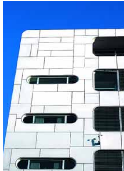
Çok katlı bina, Hamburg, Almanya | Verotec havalandırılmalı cephe sistemi
