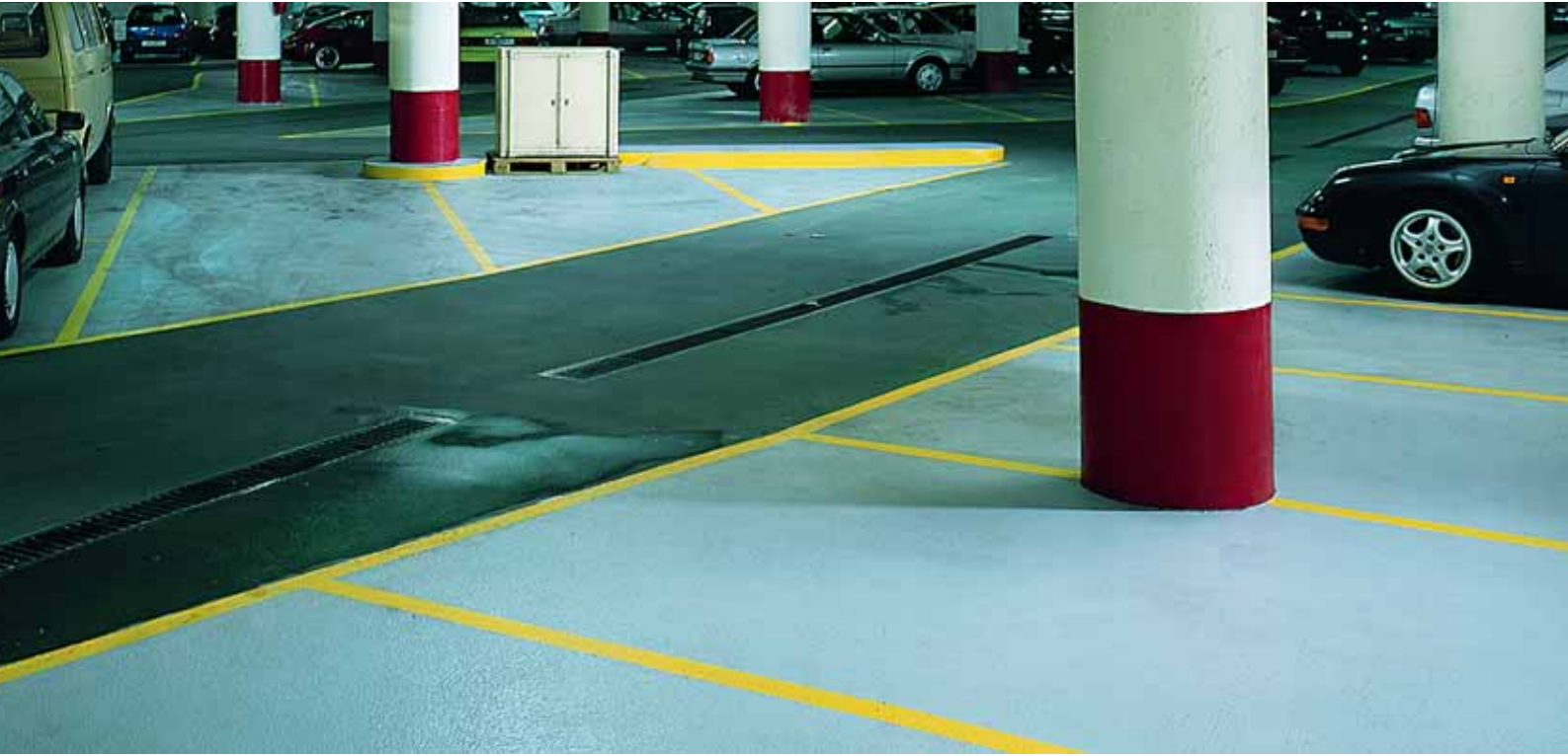
Araba garajı am Hof, Wien | StoPox GH 90 ve StoPur VS 505 ve StoQuarz zemin kaplama sistemi.
