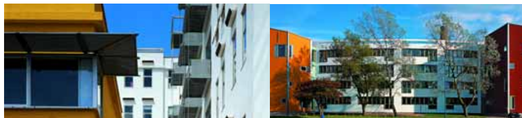
Piper Binası | İngiltere, StoTherm Classic: Malzemenin bilinçli kullanılması hataları sıfırlar.
